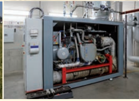
Blockheizkraftwerk
