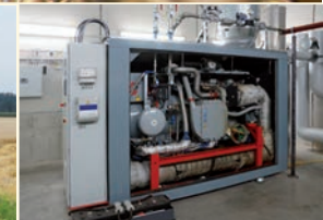
Blockheizkraftwerk
